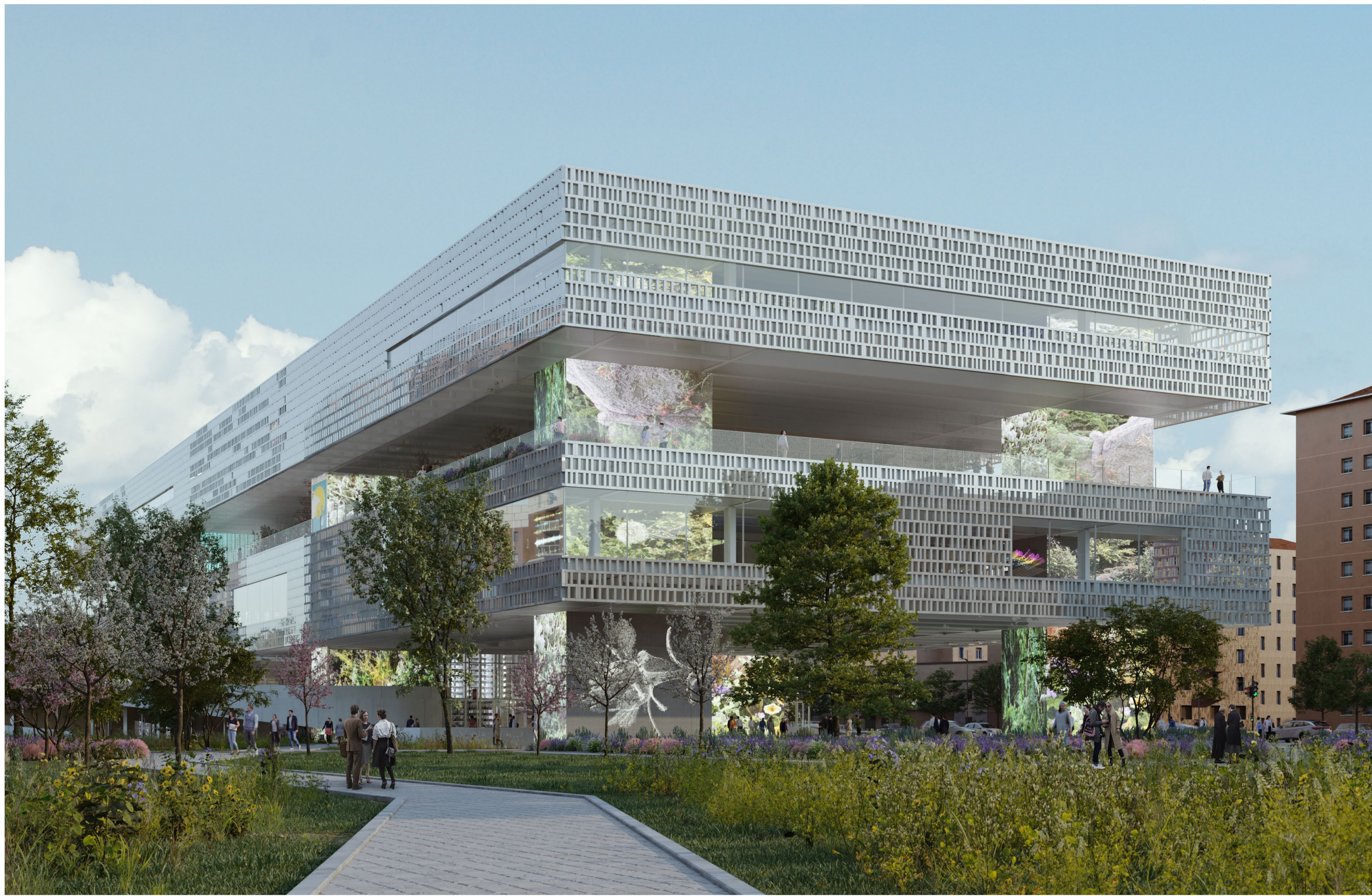
FRONTE PRINCIPALE DELLA BIBLIOTECA E DELLA NUOVA PIAZZA COPERTA
